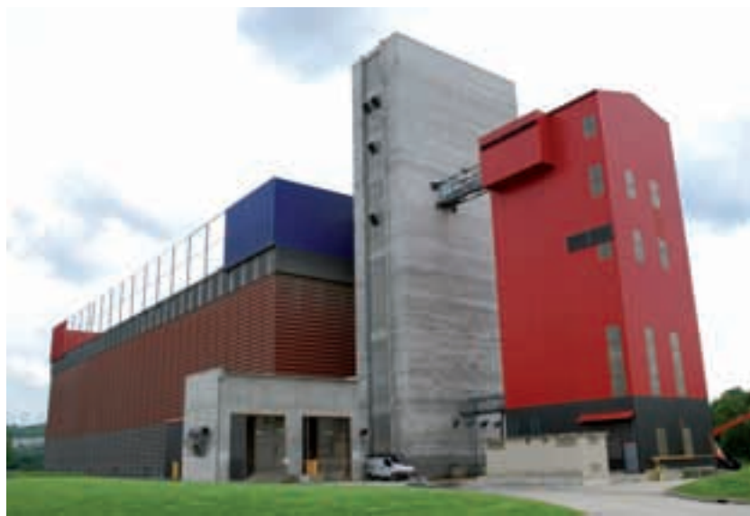
Le nouveau poste de chargement à conteneurs d'UCAYC (bâtiment rouge).
