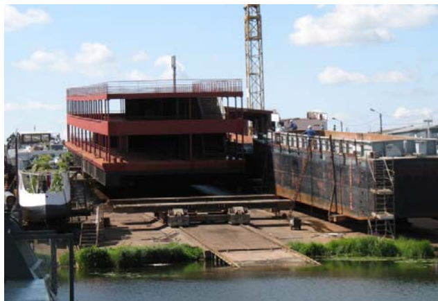
Le ponton en construction aux Chantiers de la Haute Seine
